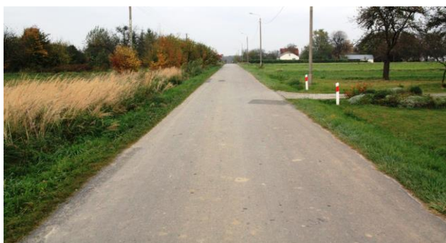
Rys. 1. Nawierzchnia asfaltowa – miejsce badań Fig. 1. Asphalt surface - a place of research
